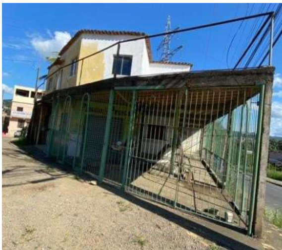
Imagem 73 – Tipologia urbana, Rua dos Diamantes. Fonte: Google, 2020.
