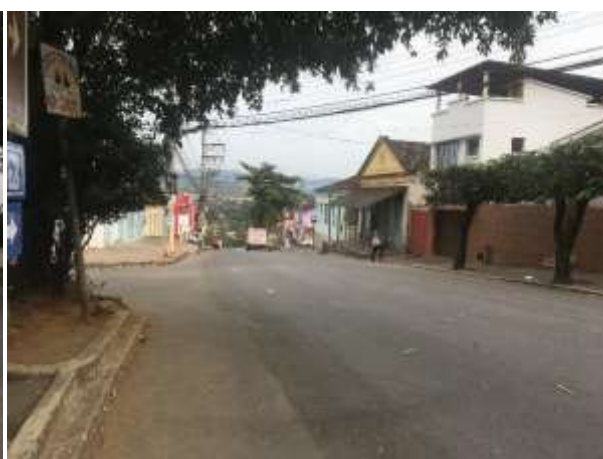
Imagem 21 – Rua Onofre de Oliveira, vista das calçadas sem acessibilidade. Fonte: acervo
