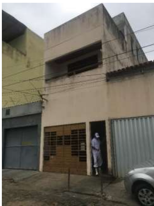
Imagem 34 – Vista do prédio, onde fica lotado o setor administrativo e contábil do empreendimento. Fonte: Acervo próprio.
