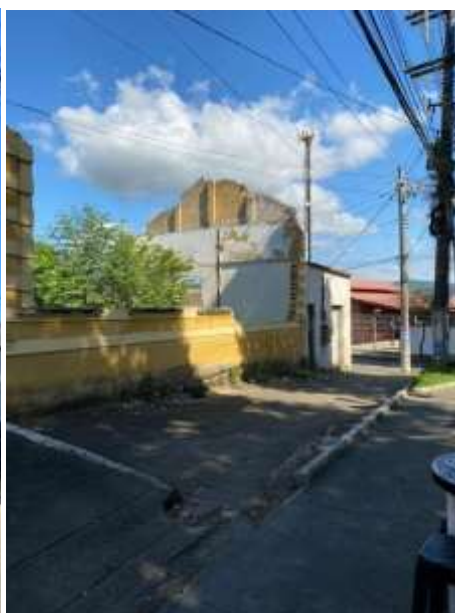
Imagem 112 – Fachada principal da instalação do futuro empreendimento. Fonte: acervo próprio, 2020.
