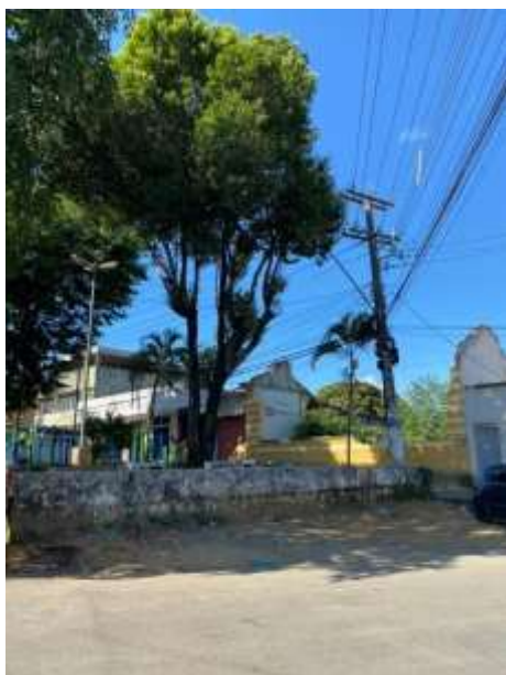
Imagem 111 – Fachada principal da instalação do futuro empreendimento. Fonte: acervo próprio, 2020.
