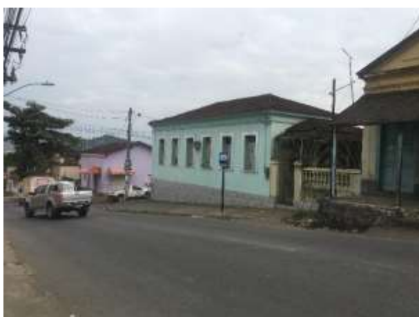
Imagem 22 – Rua Onofre de Oliveira, vista das calçadas sem acessibilidade. Fonte: acervo
